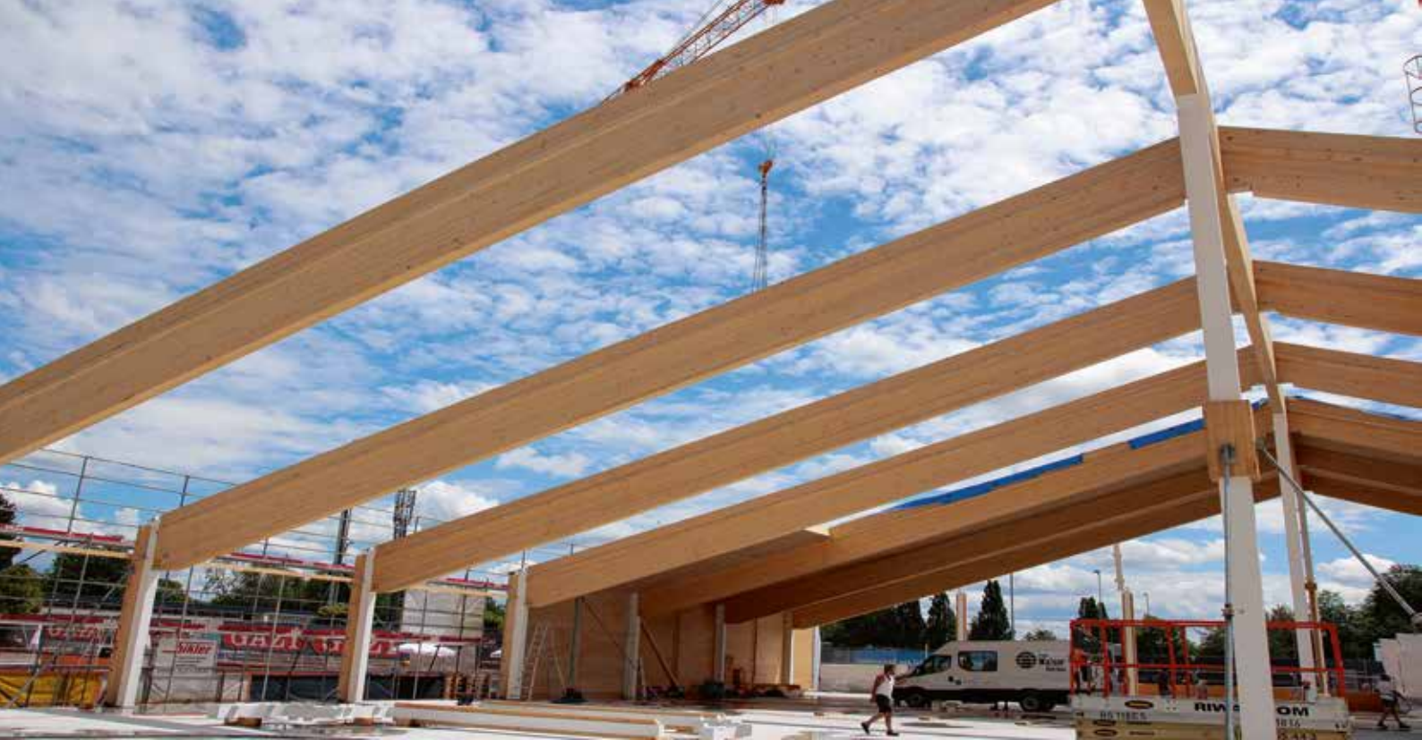
Zwischen den einzelnen Stützen werden Holzrahmenbau-Elemente mit Holzfaserdämmung eingesetzt.
